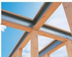
木+鉄の強い梁で建物の重さをしっかりと支えるから、地震などの大きな力が加わっても強さを発揮します。
